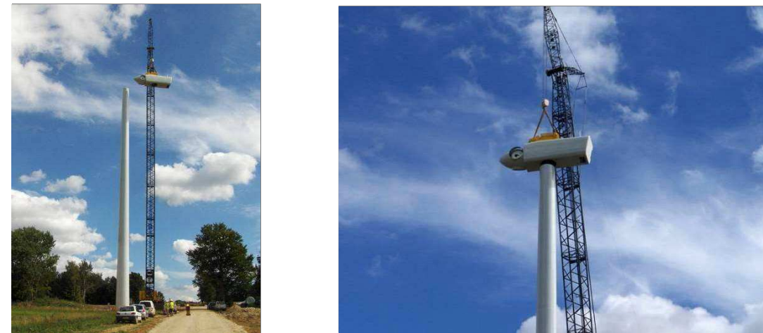
Figure 11 : Photos d'un chantier - assemblage de la nacelle
