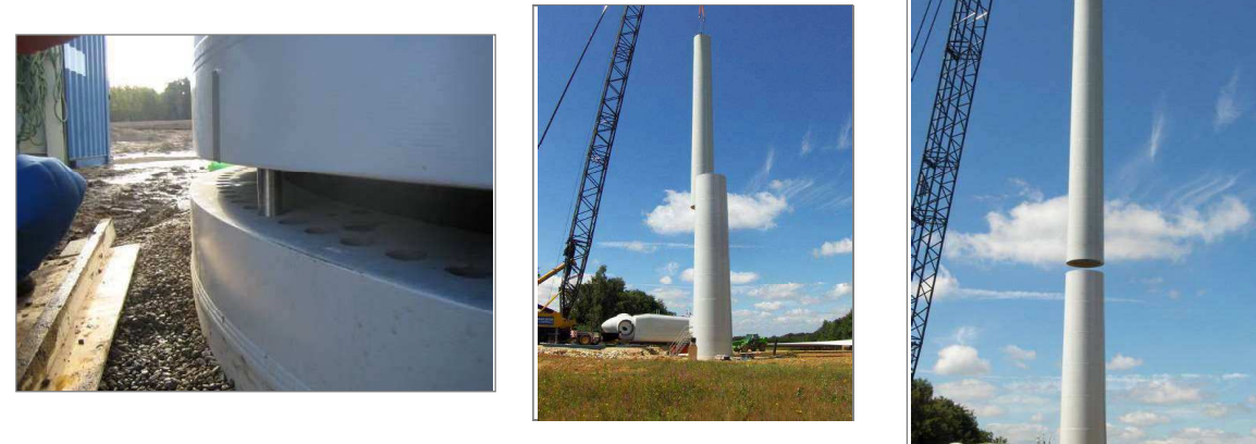
Figure 10 : Photos d'un chantier - assemblage de la tour
